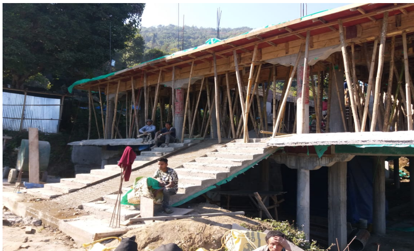
Rohbau der Schule in Soreng
