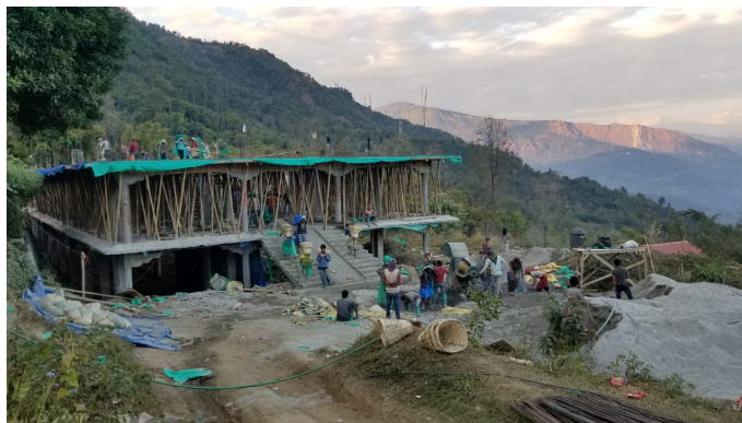
Schule im Bau
