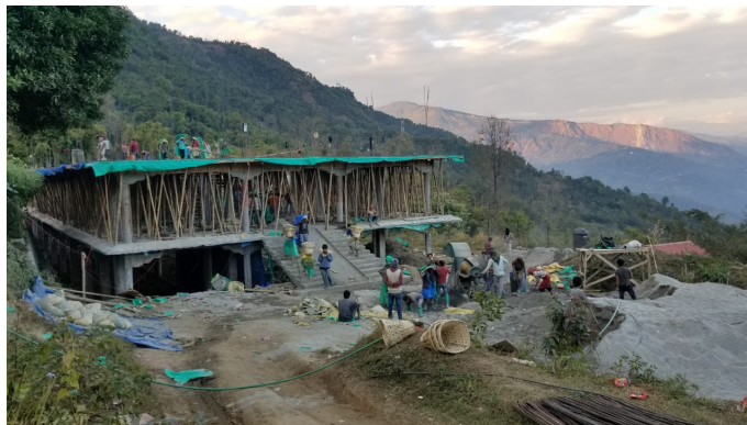
De school in aanbouw
