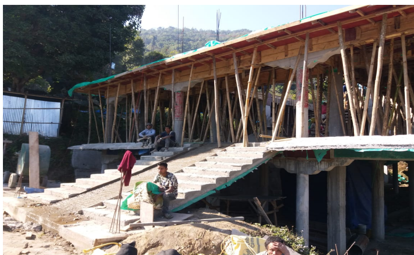
De school in aanbouw in Soreng
