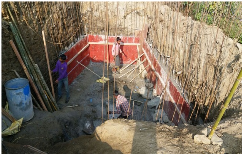
De aanleg van de fundering van het nieuwe complex in Soreng
